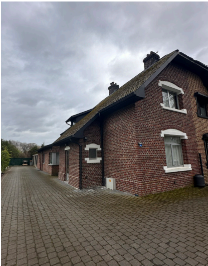
Figuur 18: Voorgevel woning
