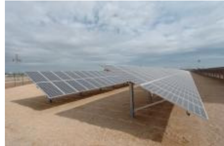
Figuur 10: PV-centrale Murcia
