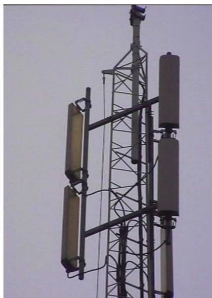
Figuur 2.2 Een GSM-mast
