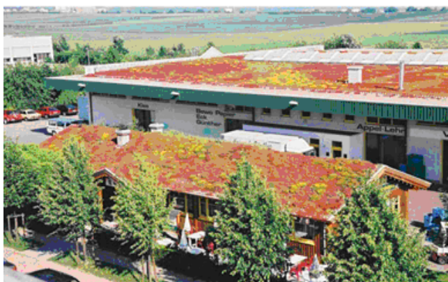
Figuur 4: Voorbeeld van een extensief groendak, Zowel op een schuin als horizontaal oppervlak.
