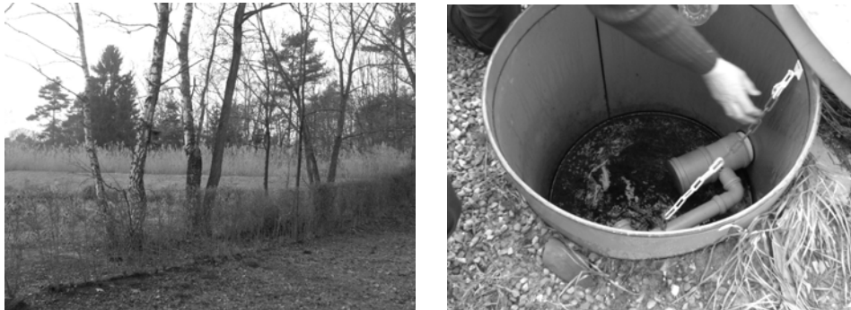
Foto 1 + 2: inplanting van KWZI in de Camping en controleput (Bron: Geerts S.)
