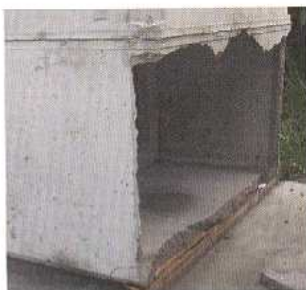
Waterzuiveringsinstallaties storten in en het afvalwater komt in de bodem terecht.
