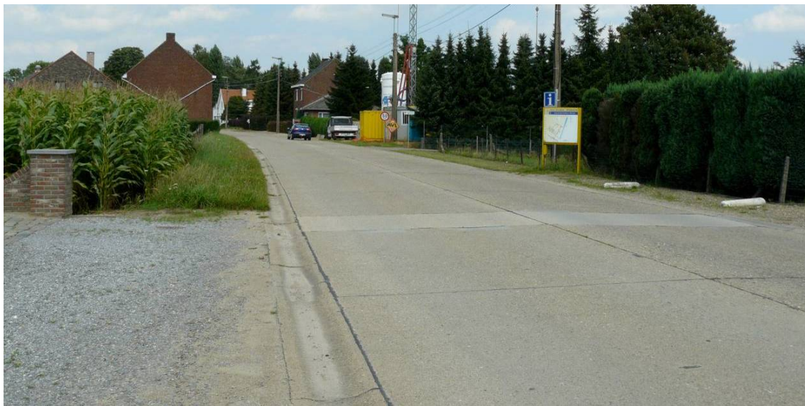
Foto 14: Dilsen: Pannenhuisstraat noord, richting Kruishoefstraat
