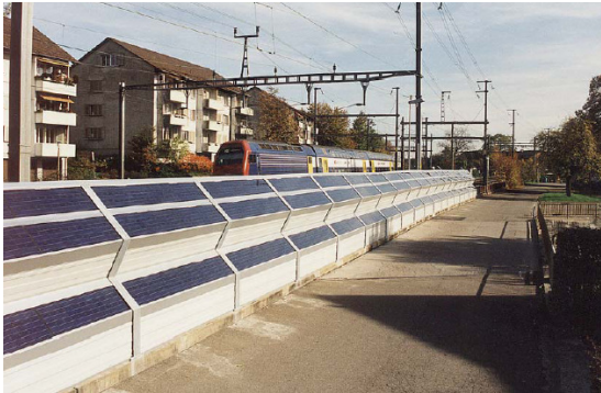
Figuur 3. 9 Zürich Bruettisellen met verticale cassette technologie
