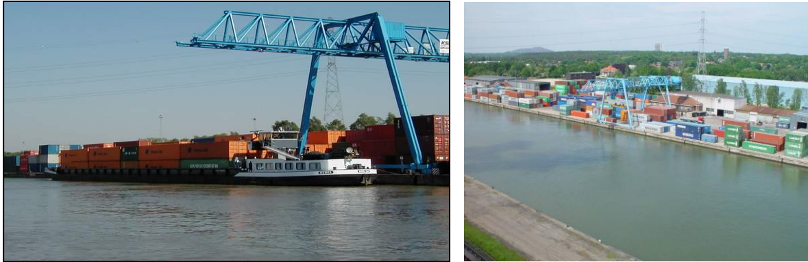
Figuur 10: Portaalkranen (Haven Genk, 2007)
