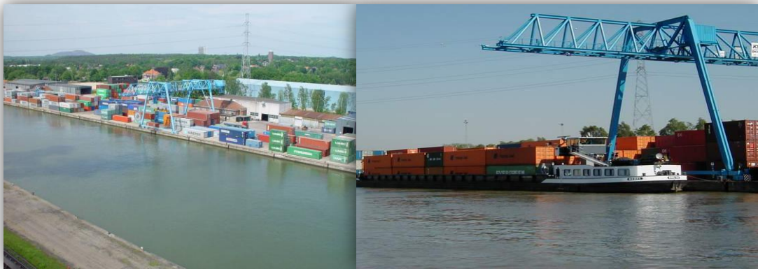
Figuur 29: Portaalkraan Haven Genk N.V. (Haven Genk, 2007)
