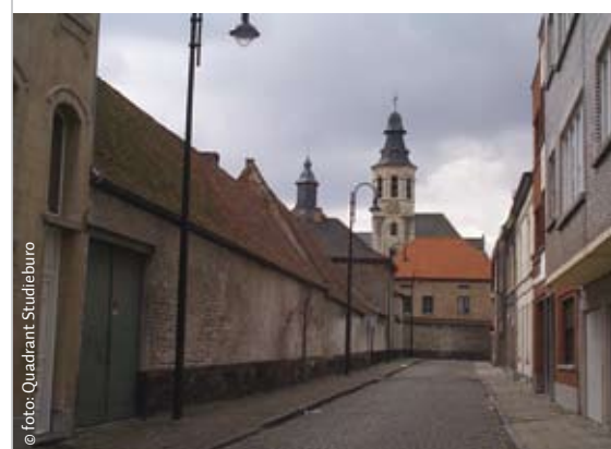
De Trooststraat vóór de heraanleg
