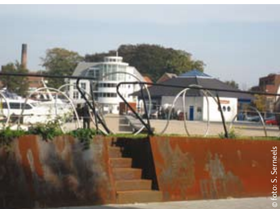
Een wand in cortenstaal vormt de scheiding tussen plein en rijweg
