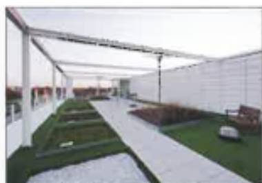
OPENLUCHTLABORATORIUM – Op het bedrijfsgebouw worden de eigenschappen van verschillende groendaken bestudeerd
