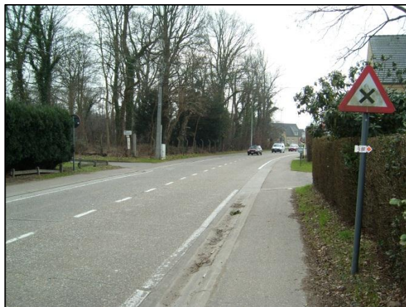
Overdemerstraat (to Kuringen)
