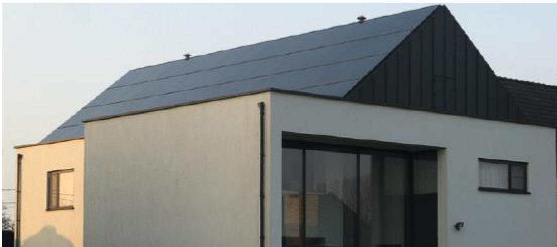
Figuur 24: Geïntegreerd fotovoltaïsch systeem in Ranst Bron: Case study Ikaros Solar (Solar Frontier Europe BVBA)
