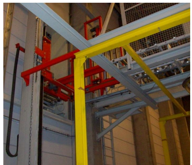
Figuur 19: het liftstelsel dat gebruikt wordt in het magazijn
