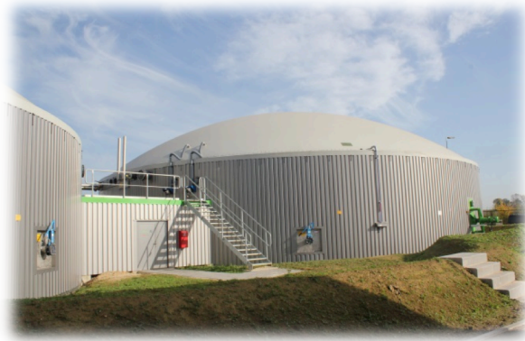
Figuur 4. Vergistingsinstallatie van Biopower in Tongeren
