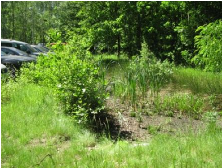
Figuur 5: wadi aan een parking, bron: Draaiboek duurzaam bedrijfsgroen (2012)
