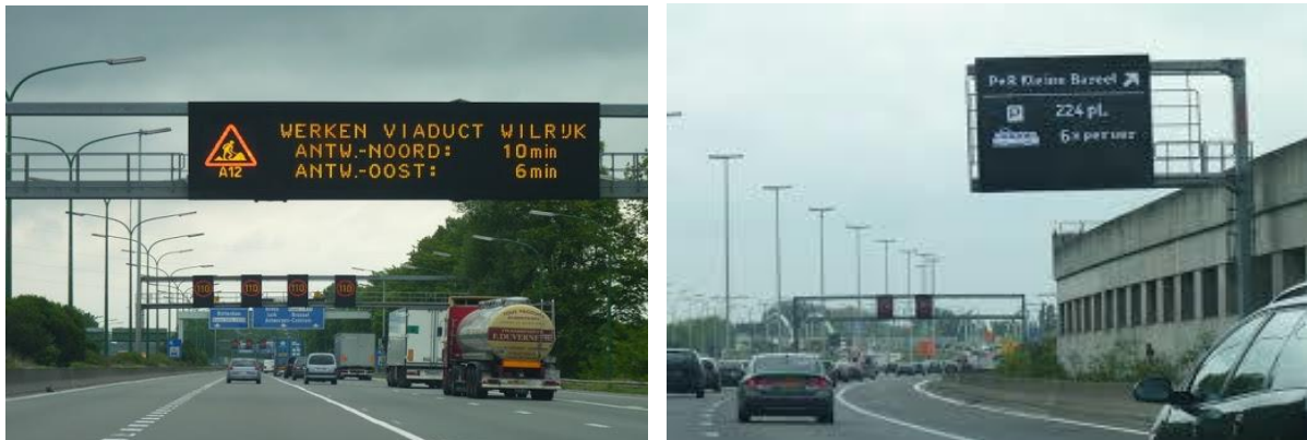
Figuur 2: Voorbeeld VMS-bord (links) en RVMS-bord (rechts)
