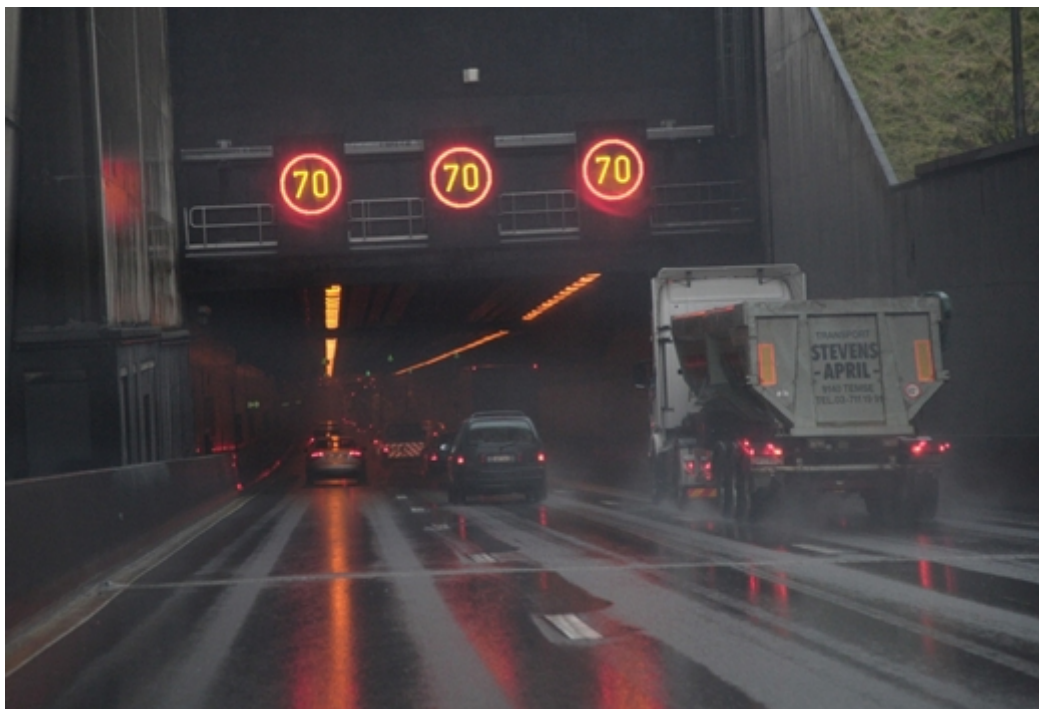
Foto 2: Dynamische signalisatieborden bij de ingang van de Kennedytunnel (Vlaams Verkeerscentrum, 2014)
