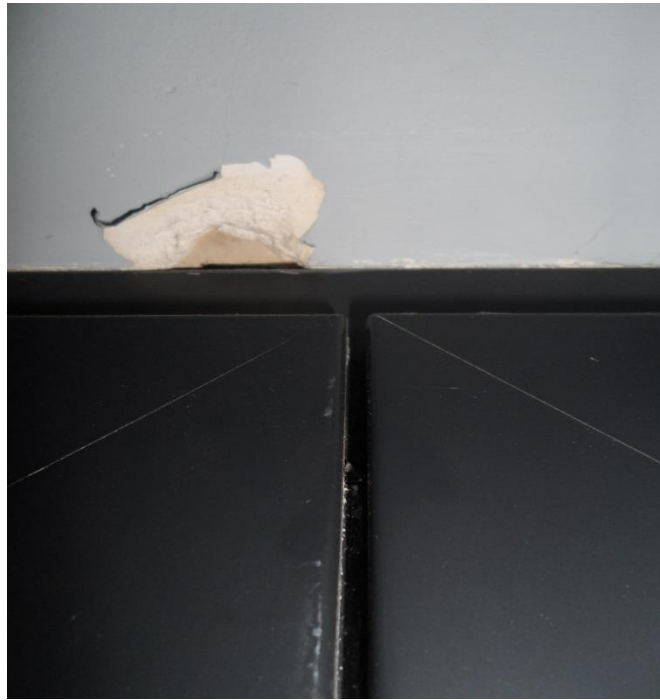
Figuur 70: : Koudebrug bij een muuranker
