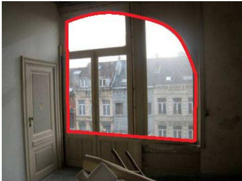
Figuur 74: De dimensie van het vast raamkader met de daarin voorziene beglazing op de 3 e verdieping [35]
