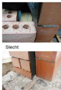
Figuur 50: doorlopende isolatie zijkant [63]
