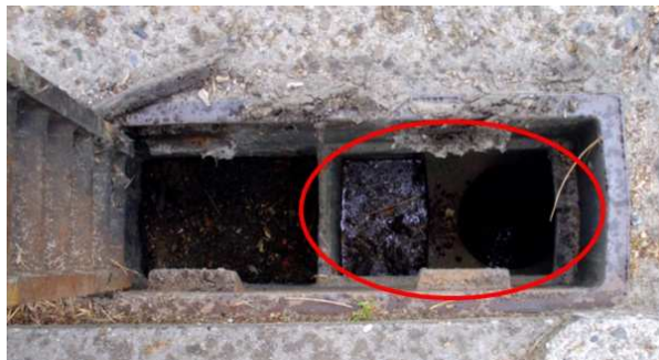
Figuur 86: Ontbrekend stankslot
