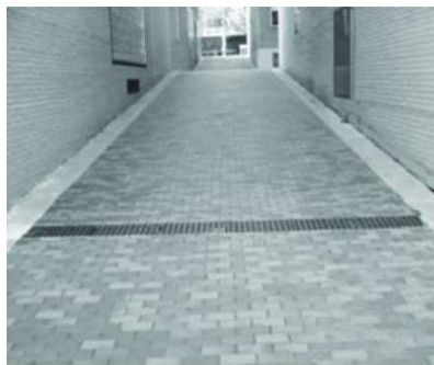
Figuur 10: Transversale inlaat[15]
