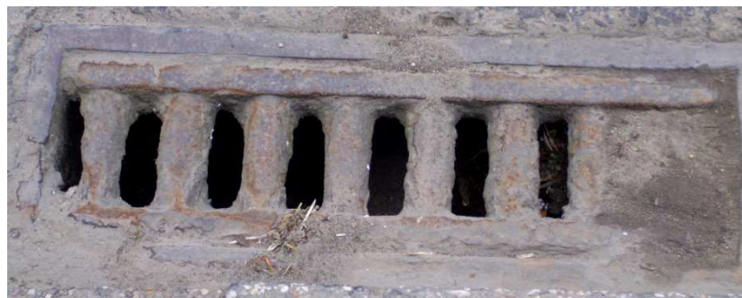
Figuur 84: Beschadigd rooster
