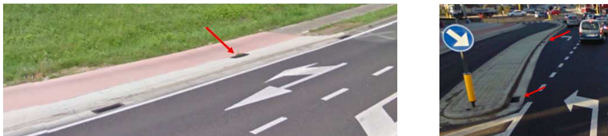
Figuur 27: Kolken op specifieke plaatsen (©2014 Google Street View)
