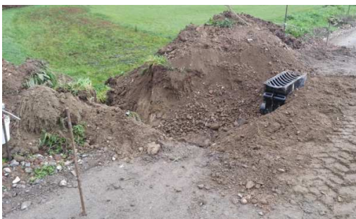
Figuur 16: Voorbeeld van een net geplaatste en aangesloten kolk
