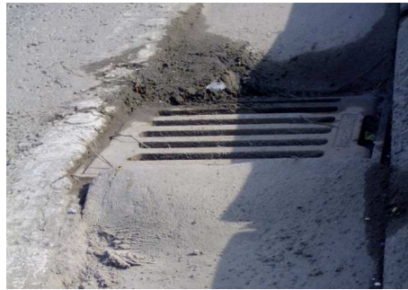
Figuur 92: Staat van de kolken op het viaduct
