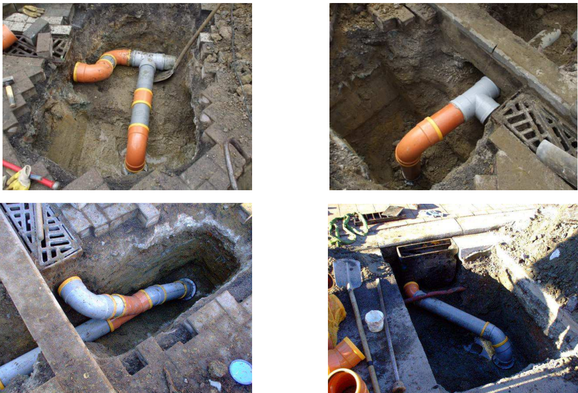
Figuur 141: By-pass aan de kolk
