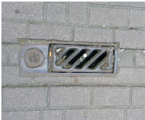
Figuur 65: Gietijzeren kolk met schroefdop
