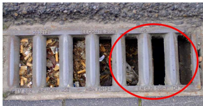
Figuur 81: Stankslot verschoven
