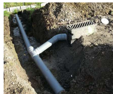
Figuur 16: Voorbeeld van een net geplaatste en aangesloten kolk
