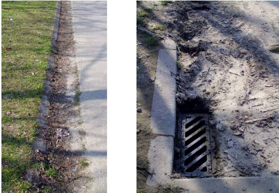
Figuur 67: Goten niet geveegd (foto Beringen-Mijn)
