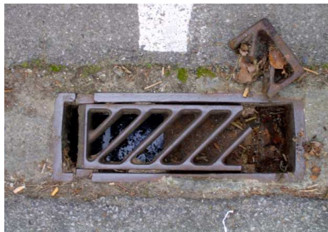
Figuur 44: Gebroken rooster
