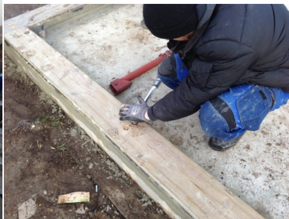
Figuur 7-4: slijpen en momentvast draaien van de segmentankers
