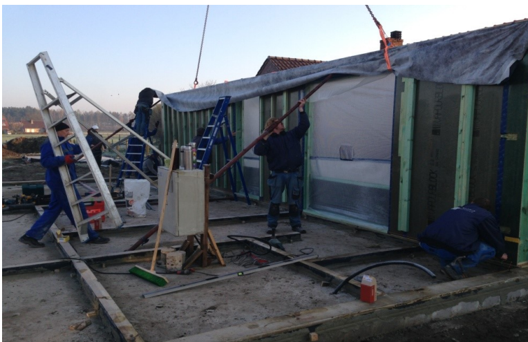
Figuur 7-11: stutten van HSB- wand
