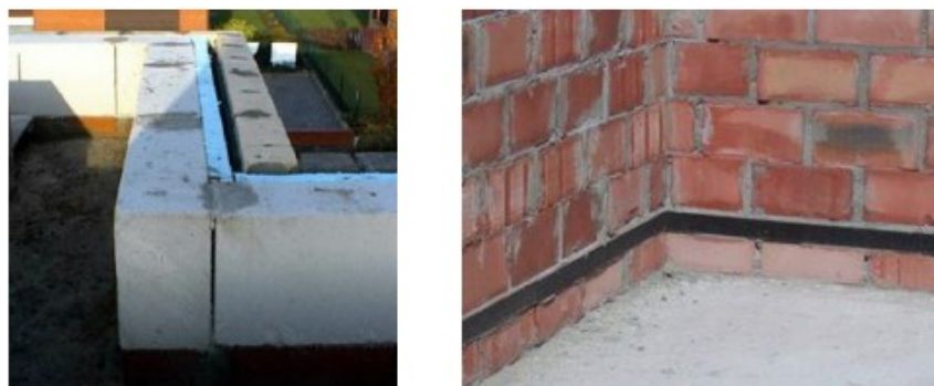
Figuur 9-3: tussenvoeging van isolerende delen
