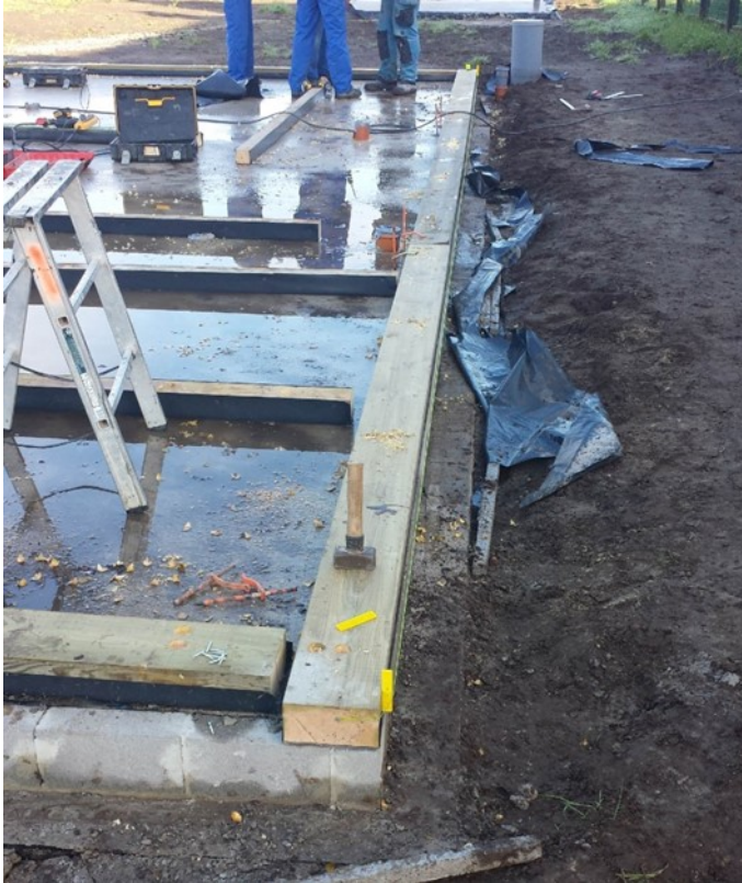
Figuur 7-2: werfsituatie plaatsing grondregel
