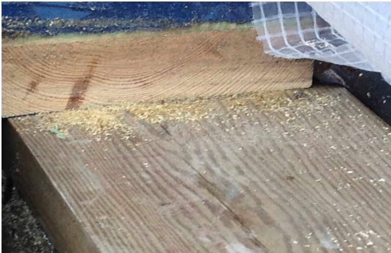
Figuur 7-10: stelregel en onderregel HSB- wand
