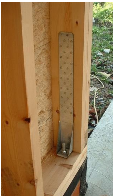
Figuur 3-3: gebruik van een tie- down [20]
