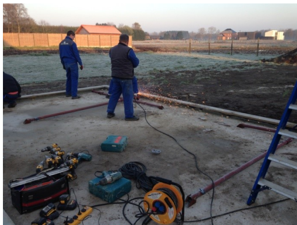
Figuur 7-4: slijpen en momentvast draaien van de segmentankers
