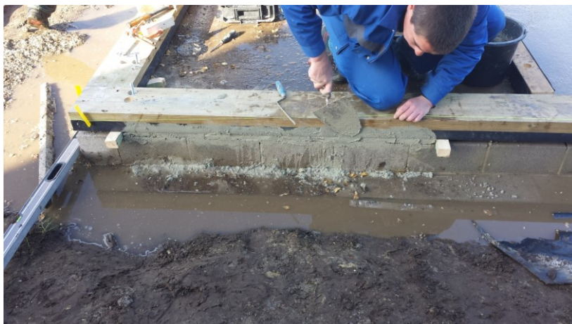
Figuur 7-8: metselwerk rondom de plaatfundering
