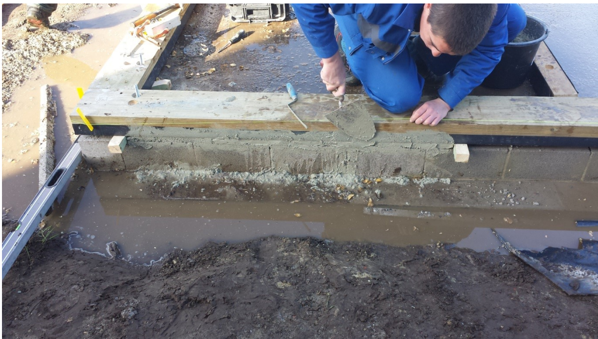
Figuur 7-3: ondervulling grondregel
