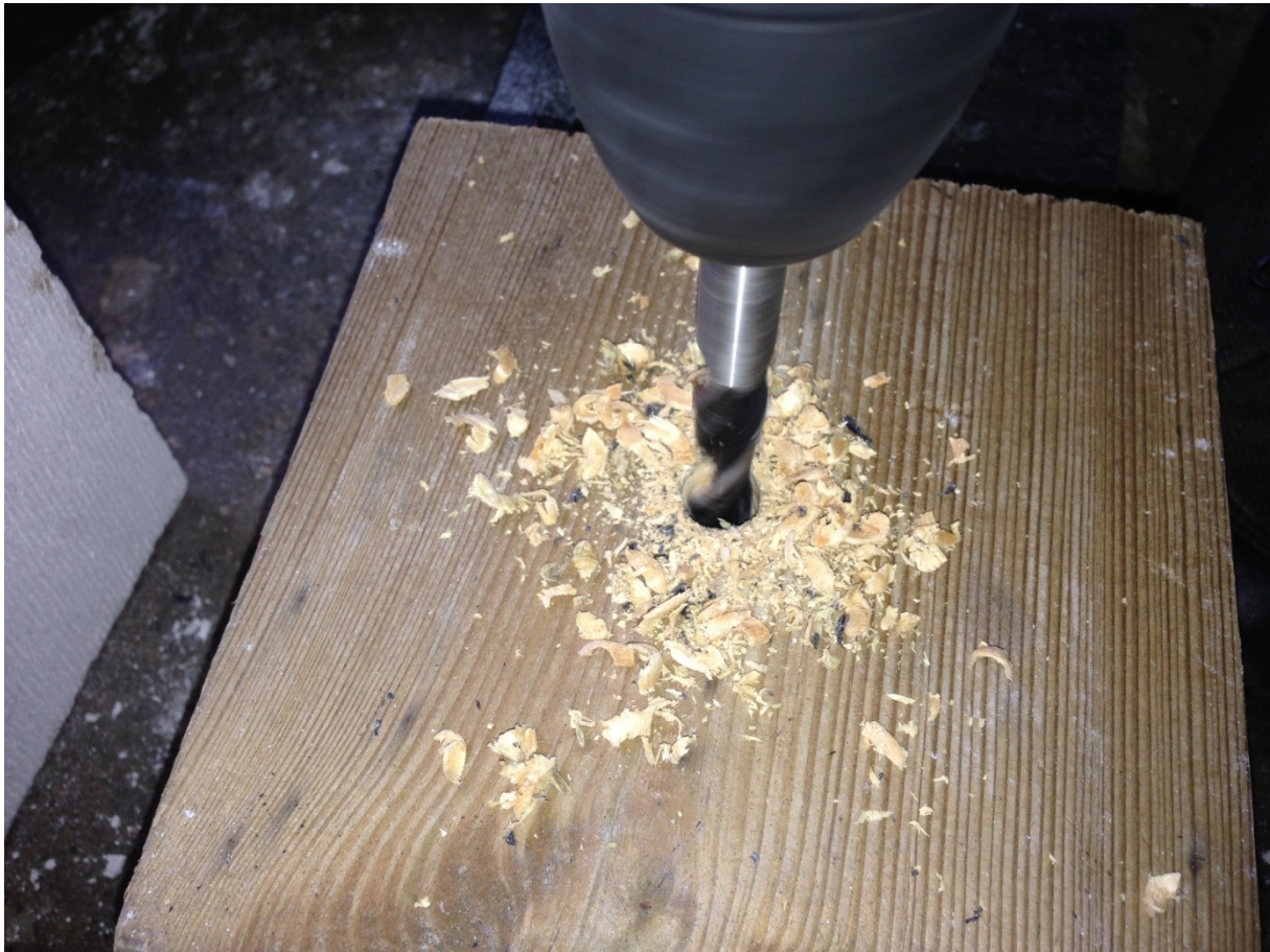
Figuur 3-8: doorboring grondregel
