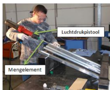
Figuur 41: vulling profielen met epoxyschuim
