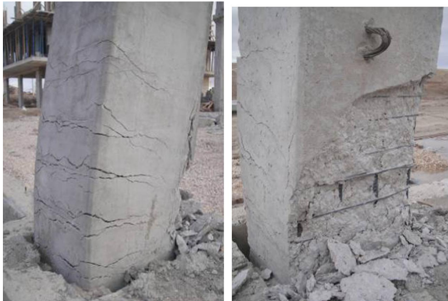
Figuur 2.5: Vorming van een plastisch scharnier onderaan de kolom [2]
