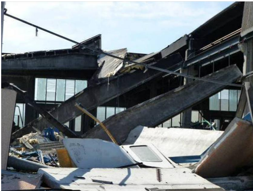
Figuur 2.3: Volledige instorting ten gevolge van afschuivende balken [1]
