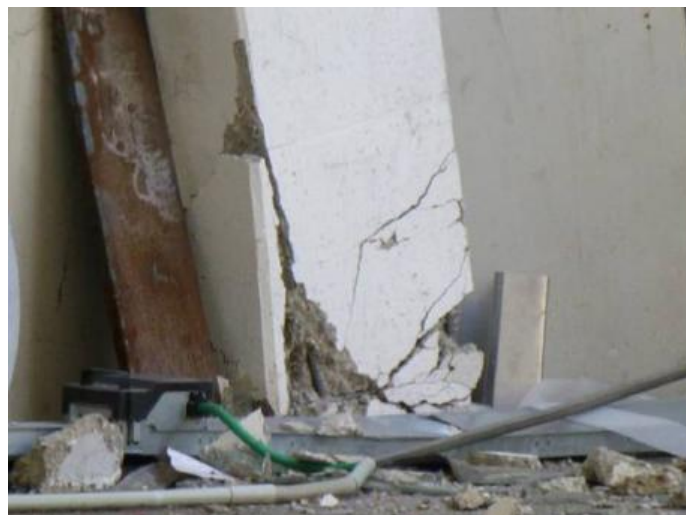
Figuur 2.2: Schade onderaan de kolom [1]
