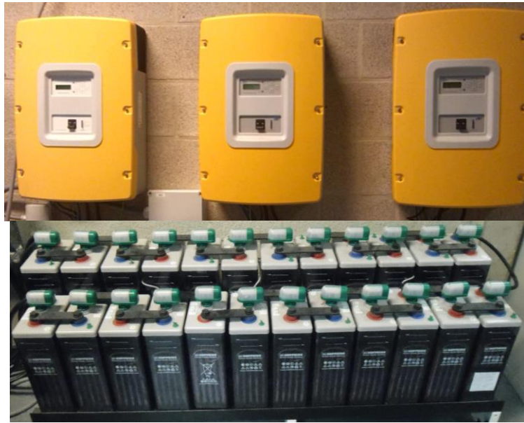
Figuur 92: Sunny Islands in combinatie met loodzuur batterijen
