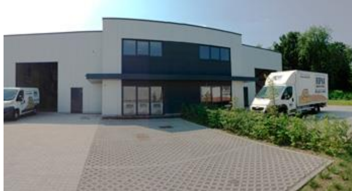
Figuur 1: Gebouw ROPAK (Ropak, 2013)
