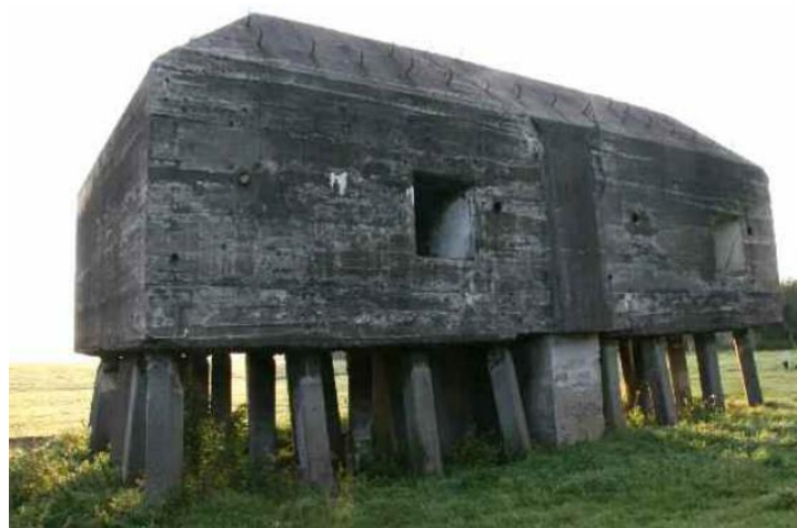
Figuur 11: Bunker in een veenrijk gebied gefundeerd op palen in de Tweede Wereldoorlog
