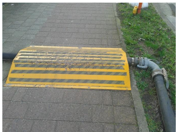
Figuur 21: Afvoer via drempels geplaatst op het fietspad
