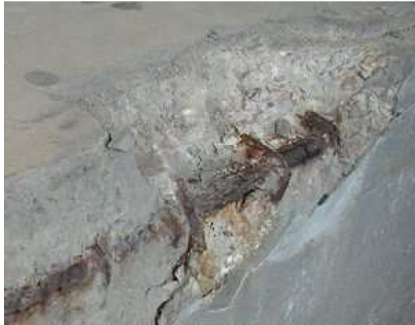
Figuur 33: betonrot
