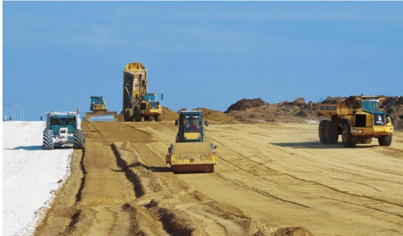
Figuur 2: Grondverbetering toegepast in de praktijk [2]. Voorbereiden, strooien, mengen, beluchten en verdichten van de grond.
