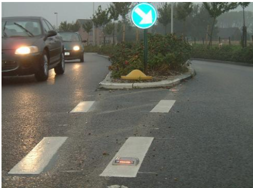
Figuur 1 & 2: Reflecterende elementen en LED verlichting ingewerkt in de wegmarkering [1]
