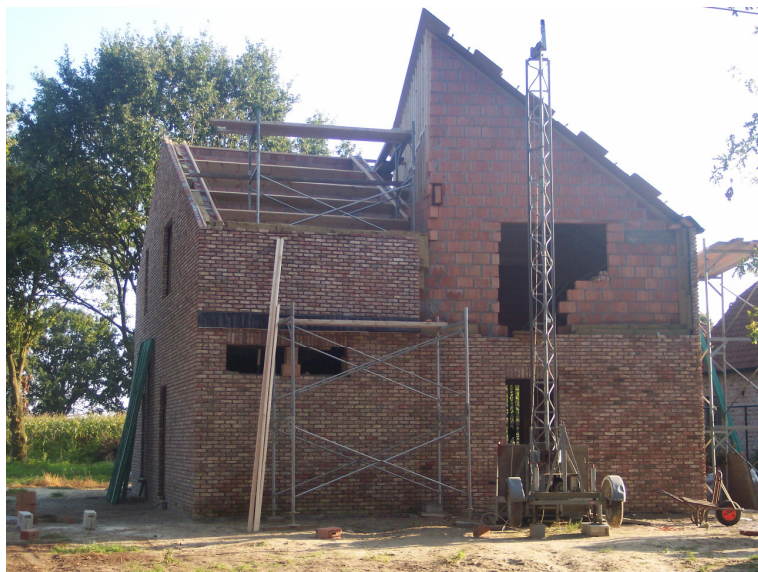
Foto 1: Vooraanzicht van de woning in aanbouw
