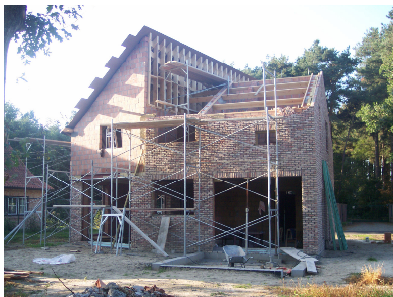
Foto 2: Achteraanzicht van de woning in aanbouw
