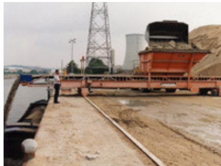
Figuur 26: Kaaimuur Bron: Binnenvaart, 2006-2007
