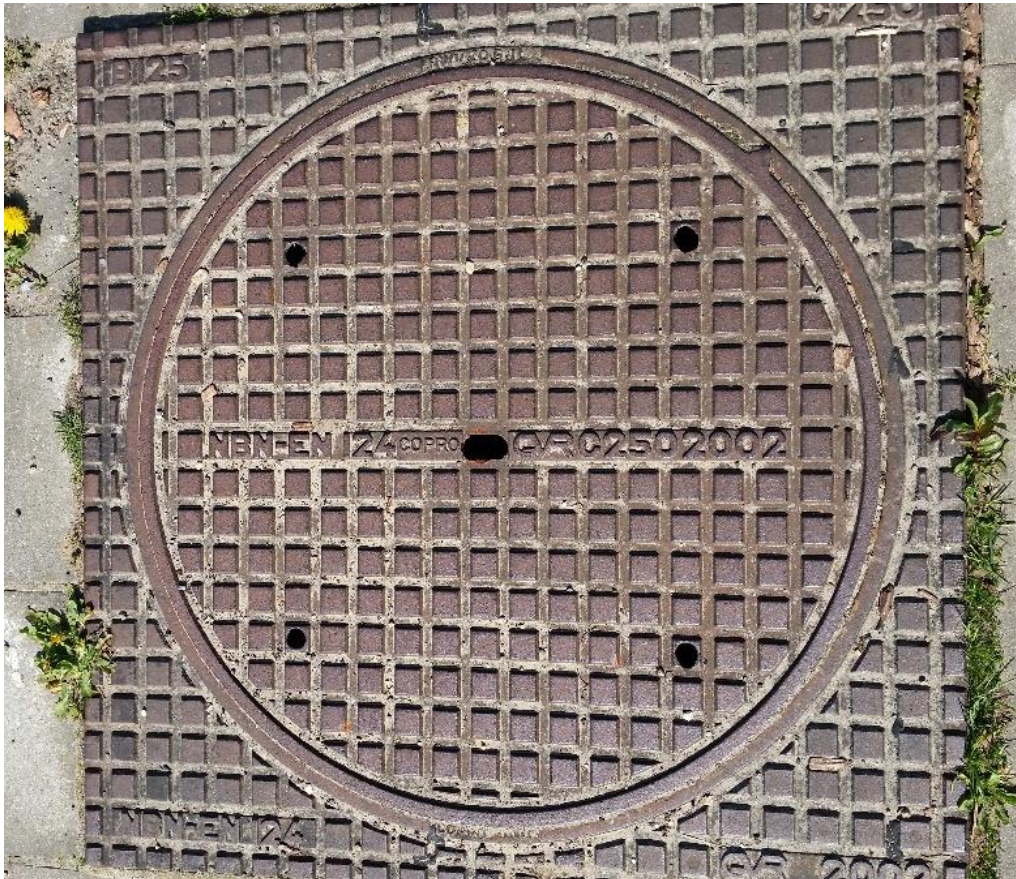
Figuur 22: Riooldeksel Mommersbosweg Zonhoven
