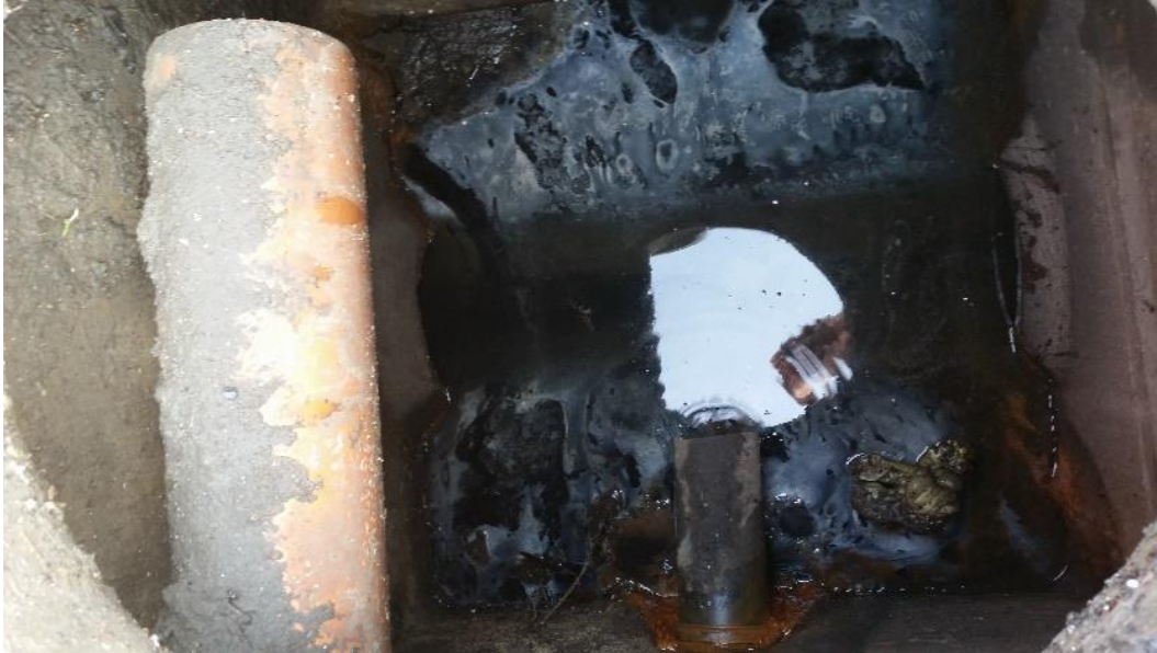
Figuur 37: Lozing op DWA-riolering Tivoli Borgloon
