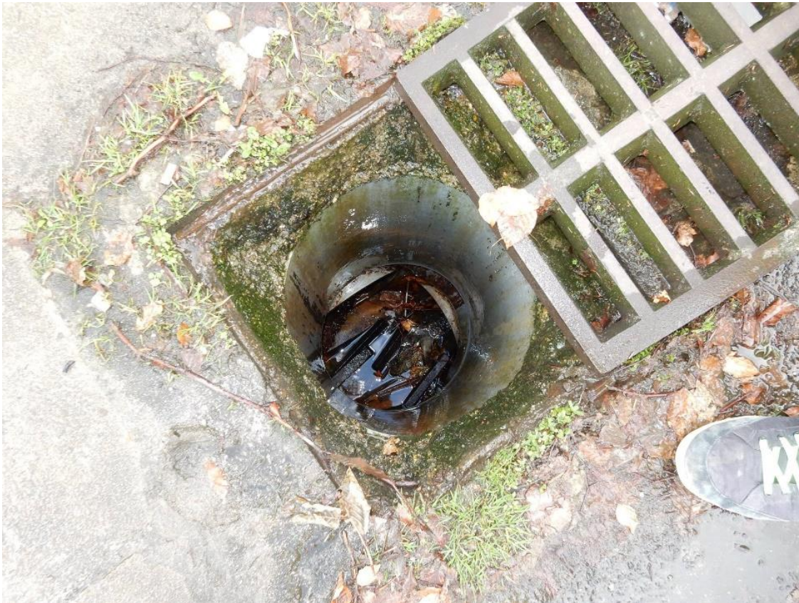
Figuur 12: Gemengde collectorbuis
