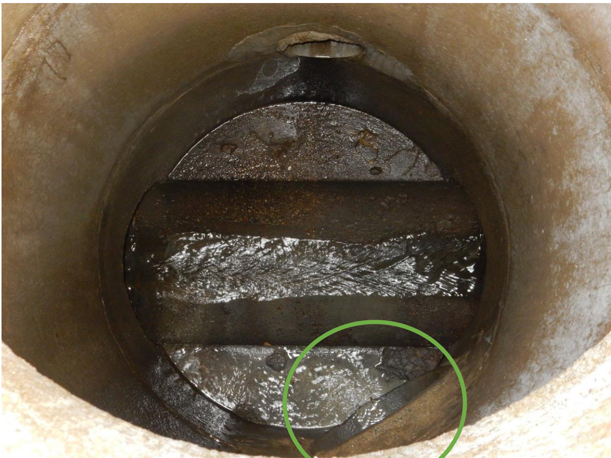
Figuur 14: Lozing van gemengde collectorbuis op RWA-riolering
