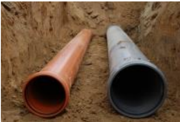
Figuur 9: Kleurcode rioolbuizen [19]
