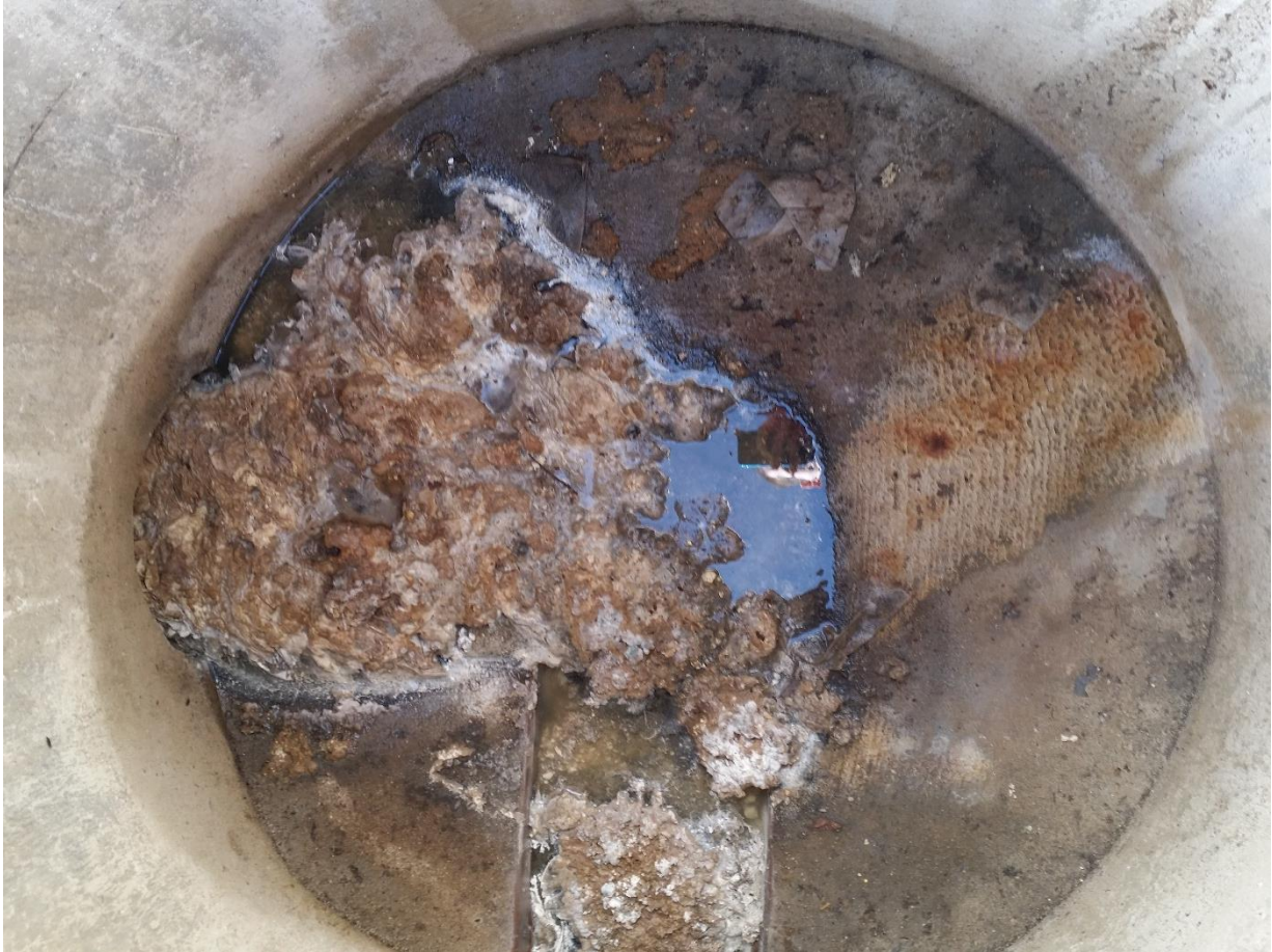
Figuur 19: Verstopping DWA-inspectieput
