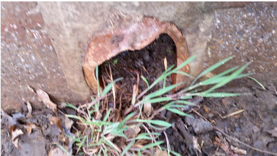
Figuur 26: Lozing hemelwater op gracht
