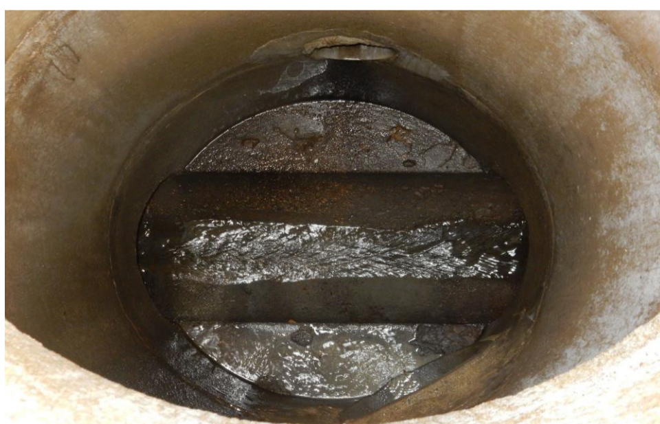
Figuur 3: Lozing vuil water op RWA-riool (rechtsonder)
