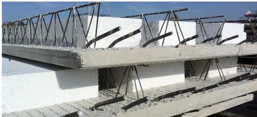
Figuur 22: EPS-vloersysteem [19]
