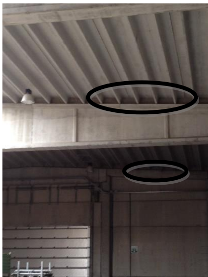
Figuur 39: Stortlaag beton op liggers [18]
