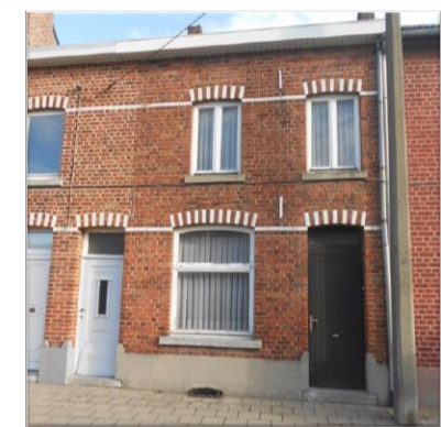
Woning uit 1920 (binnenisolatie)
