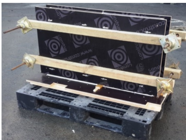
Figuur 1: Proefbekisting
