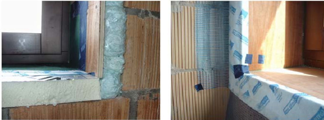
Figuur 84: Afwerking multiplex raamkader. [35]
