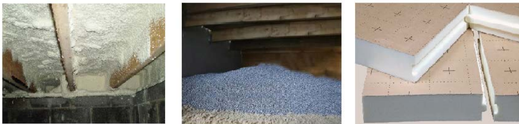
Figuur 18: Verschillende isolatie types bij vloerisolatie. [12]
