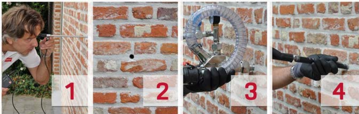
Figuur 2: Stappenplan spouwmuurisolatie. [13]
