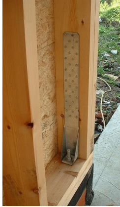
Figuur 13: Verankering eindstijl: tie-down.[4]
