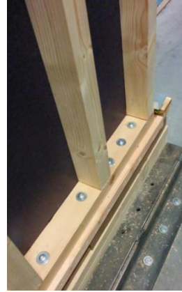
Figuur 14: Verankering onderregel
