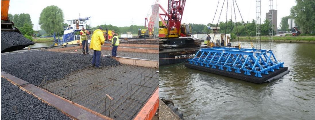
Figuur 82: (a) Asfaltmengsel in mal plaatsen; (b) Asfaltmat in kanaal plaatsen, [34]
