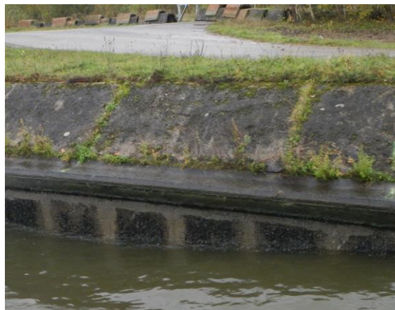
Figuur 72: Herstelling betonnen damwand
