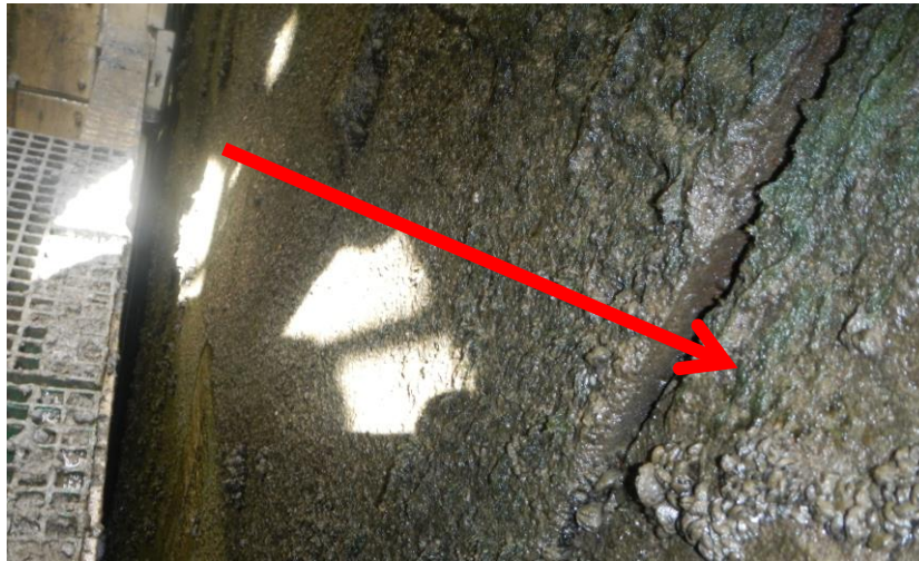
Figuur 11: Verschuiving damwanden ten opzichte van elkaar
