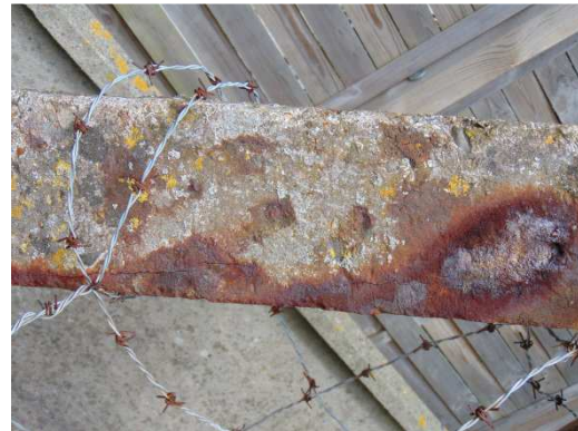
Figuur 6: Detail chlooraantasting
