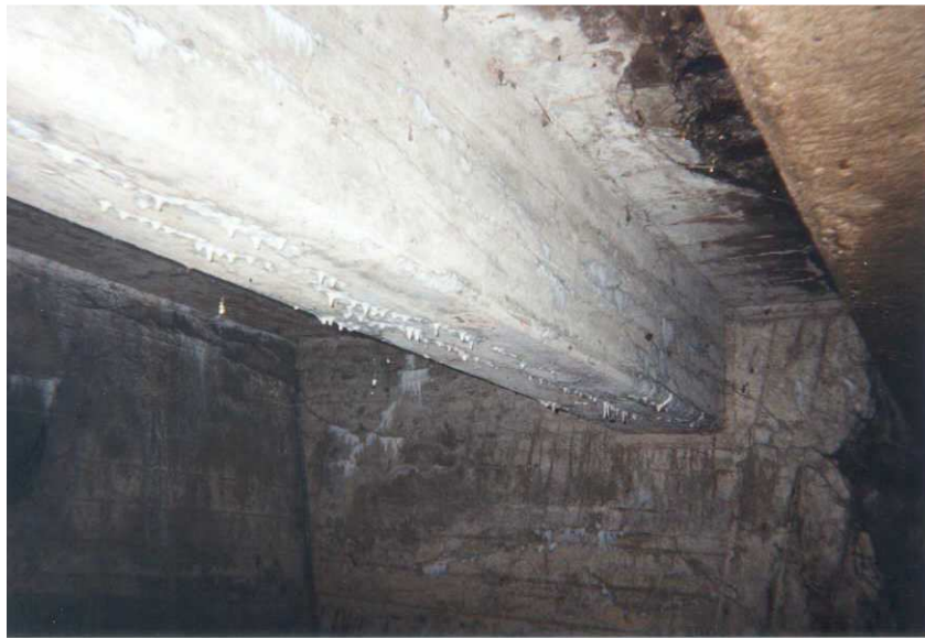
Figuur 2: Kegelvorming ASR (3)
