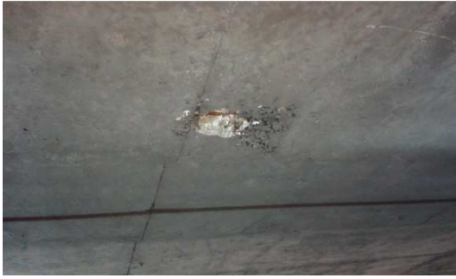
Figuur 37: Grindnest met blootliggende wapening
