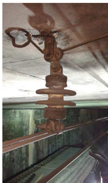
Figuur 36: Verbindingsstructuur tussen stroomleiding en beton
