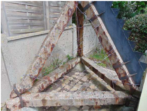
Figuur 5: Chlooraantasting waargenomen in zeeomgeving
