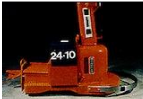
Figuur 6: De eerste AGV (1953) door Barrett Electronics[5]
