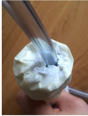
Figuur 17: Isolatie leidingen
