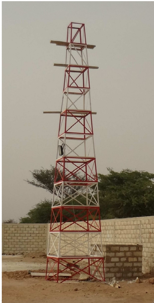
Figuur 31: Mast windmolen 'Futur du Sénégal'
