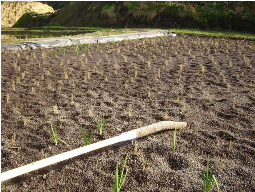
Figuur 27: Bio-filtratie, rietveld
