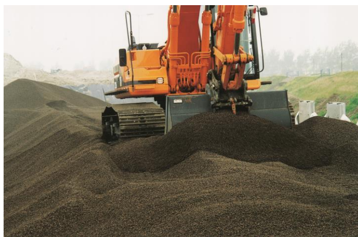
Figuur 20: Argexkorrels als lichte aanvulling achter stalen damwanden
