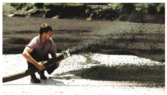
Figuur 18: Argexkorrels kunnen op de juiste plaats geblazen worden met een rendement van 30 m 3 /uur
