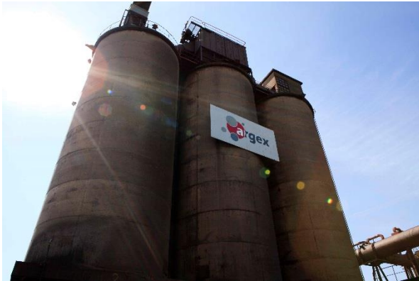
Figuur 12: Silo's voor gezeefde stock
