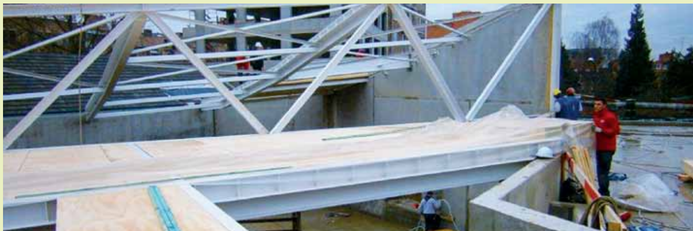
De start van het plaatsen van de dakpanelen op de metalen draagconstructie van het groot auditorium
