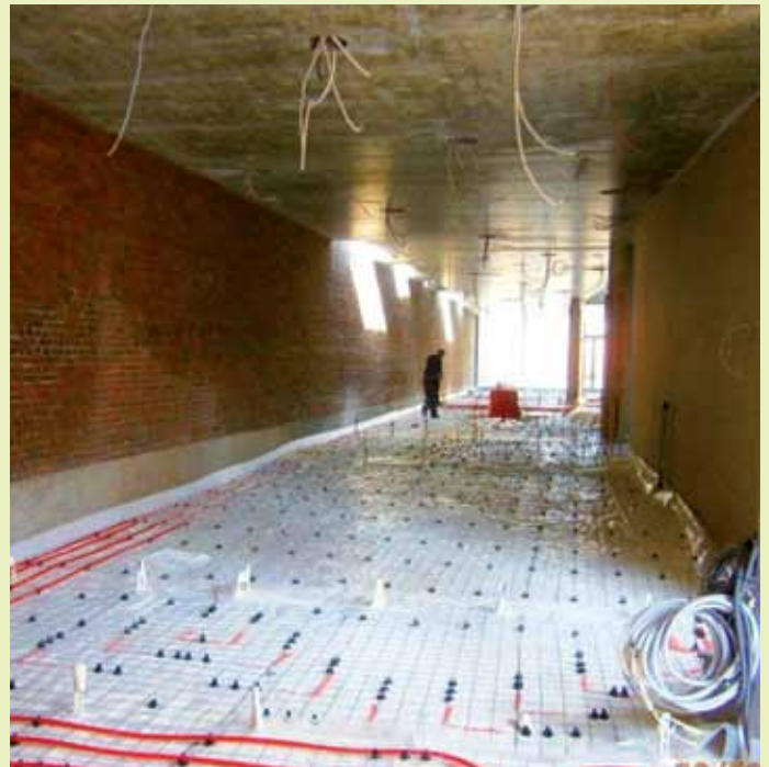
Aanleggen van vloerverwarming
