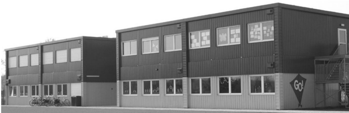
Figuur 1: Permanent schoolgebouw met Warsco Units [1]
