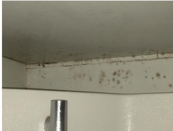
Figuur 65: schimmelgroei in badkamer
