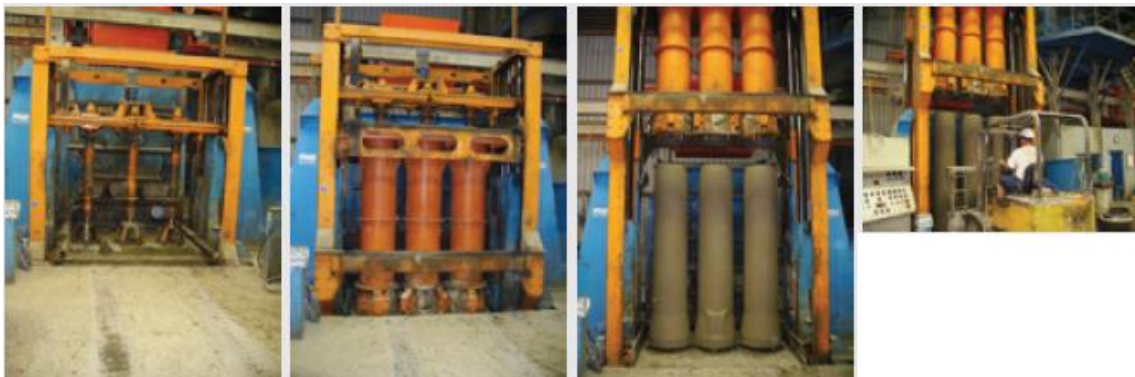
Figuur 3: Productieproces; a) beginfase; b) vullen en trillen van de mallen; c) ontkisting; d) transporteren [3]
