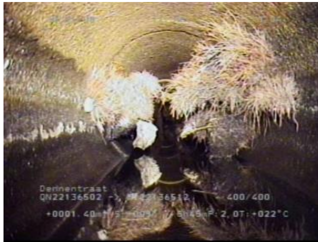
Figuur 8: wortelgroei [foto uit inspectievideo's]
