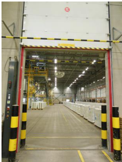
Figuur B.9: Zicht op branddeur ( Losplaats 2 )
