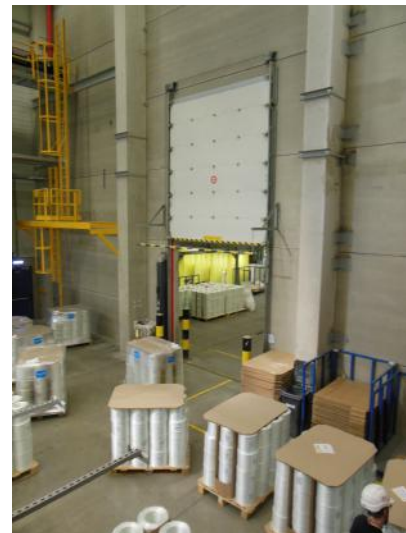
Figuur B.10: Zicht op branddeur ( Losplaats 2 )
