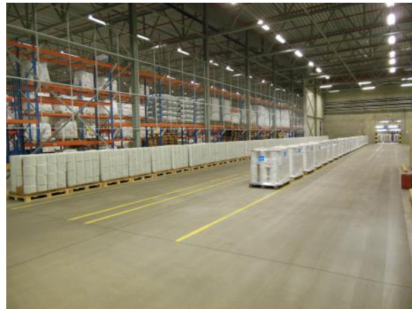
Figuur B.2: Magazijn ( zicht op branddeur )
