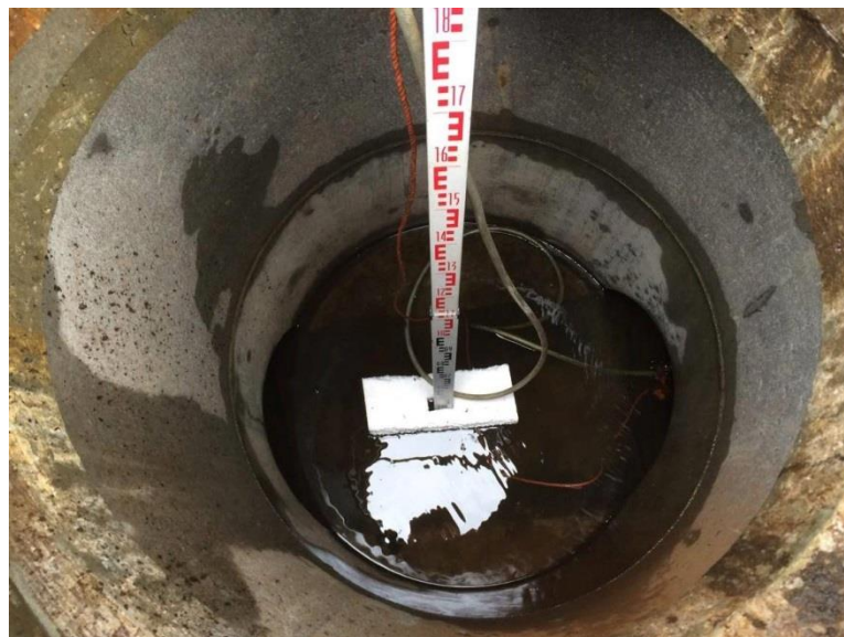
Figuur 32: Proefopstelling infiltratieproef in Bree
