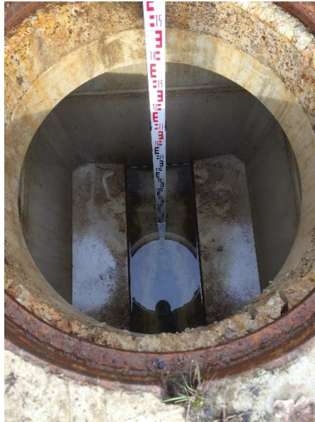
Figuur 21: Opstelling meetbaak
