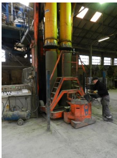
Figuur 9: Ontkisting van de poreuze betonbuis
